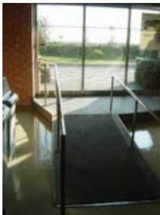
図 4-24 屋上入り口のスロープ
