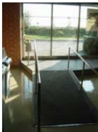
図 4-24 屋上入り口のスロープ
