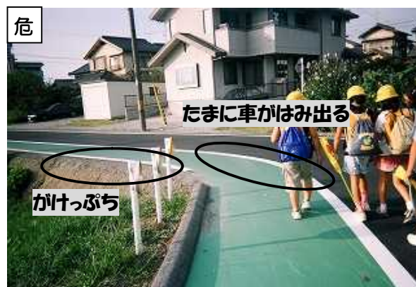
図 4-4 路肩の写真例(a-8-1)
