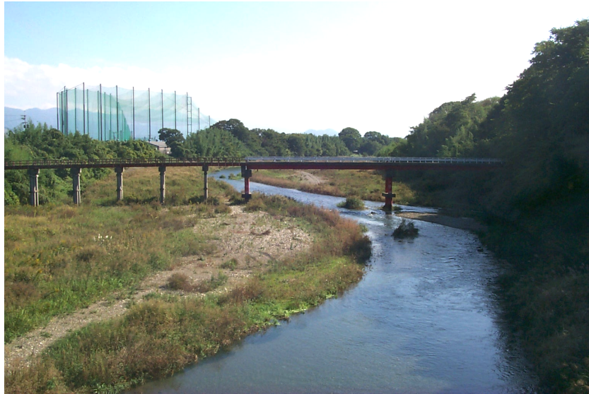
写真 3-2 犬上川 今橋を下流より撮影
