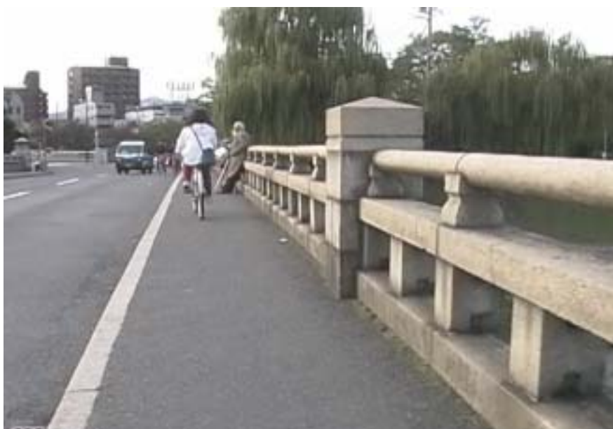
図 4-3-4 「直線平坦」タイプ (鴨川/出町柳駅周辺)
