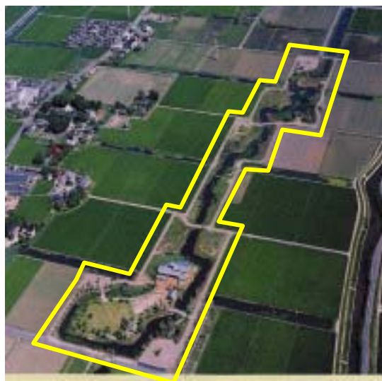
図 2-6 ひょうたん島公園施工後 （佐賀中部農林事務所提供）
