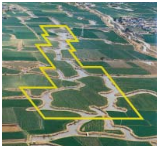
図 2-5 ひょうたん島公園施工前 （ひょうたん島公園パンフレットより）
