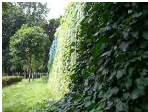
図 4-51 緑のカーテン(NM 氏・鶴ヶ島工場 立体駐車場に設置の緑のカーテン)
