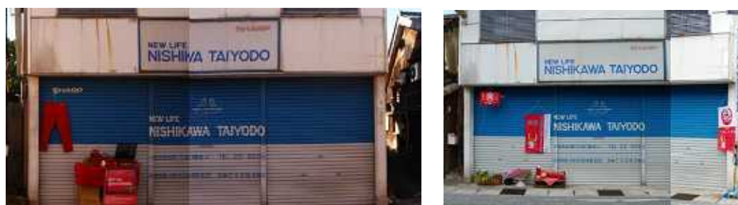
図 4-119 N 電気店 2007 年外観（写真左）と 2008 年外観（写真右）
