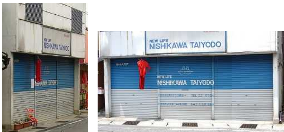
図 4-118 N 電気店 2005 年外観（写真左）と 2006 年外観（写真右）
